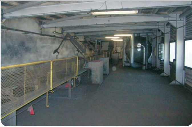
Fot. 3* i 4. Galeria nawęglania nad kotłami
